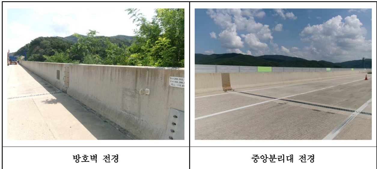
【사진 15.3.46】 방호벽 및 중앙분리대 전경
