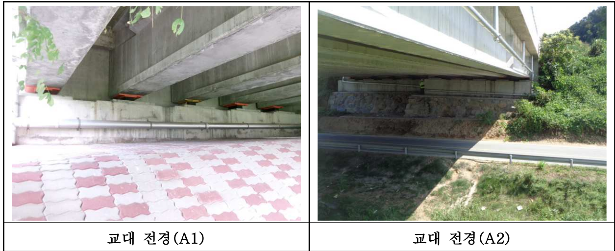
【사진 15.3.31】 교대 전경
