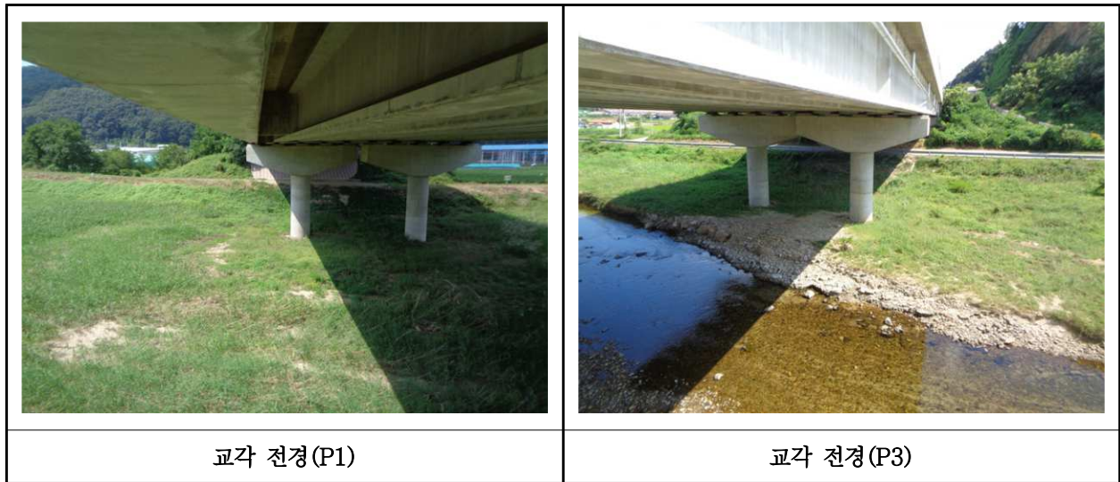
【사진 15.3.33】 교각 전경
