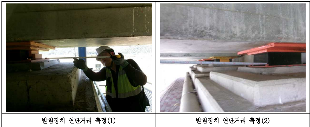
【사진 15.3.14】 교량받침장치 연단거리측정
