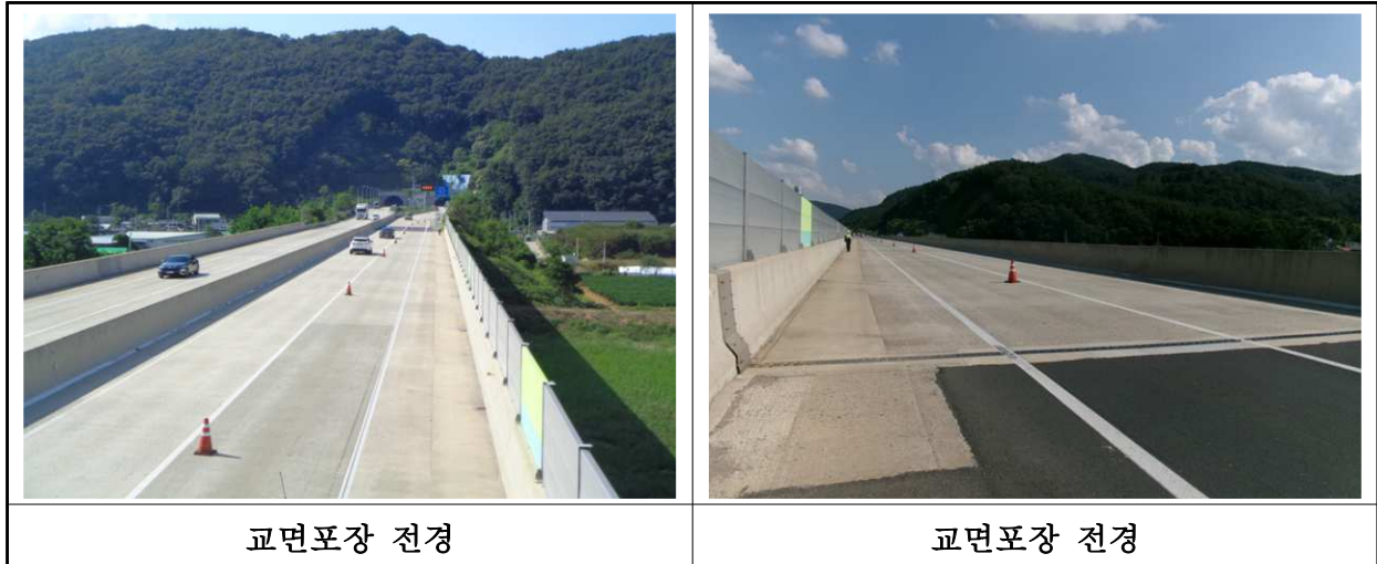
【사진 15.3.19】 교면포장 전경
