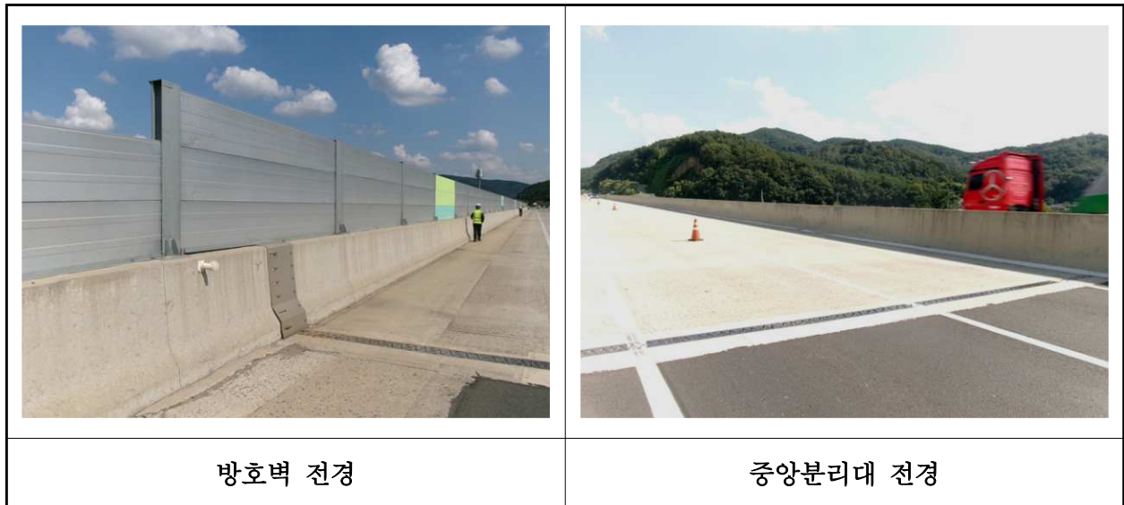
【사진 15.3.23】 방호벽 및 중앙분리대 전경
