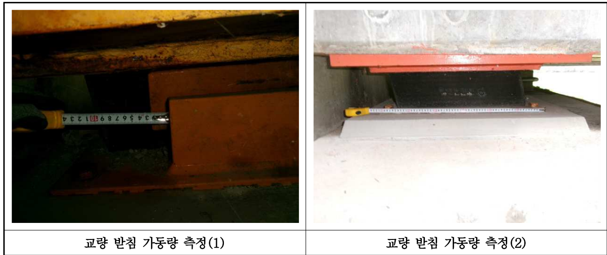
【사진 15.3.38】 교량받침 이동량 측정
