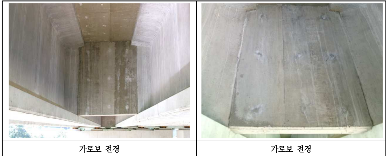
【사진 15.3.29】 가로보 전경
