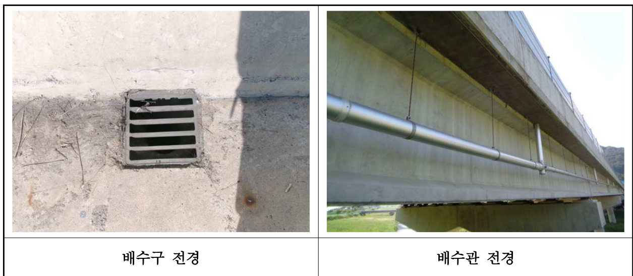
【사진 15.3.21】 배수시설 전경
