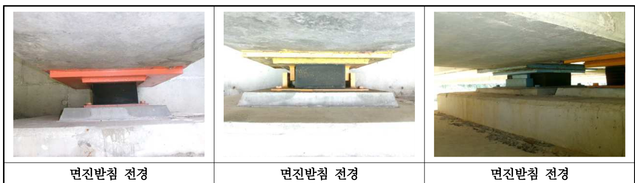
【사진 15.3.35】 교량받침 전경
