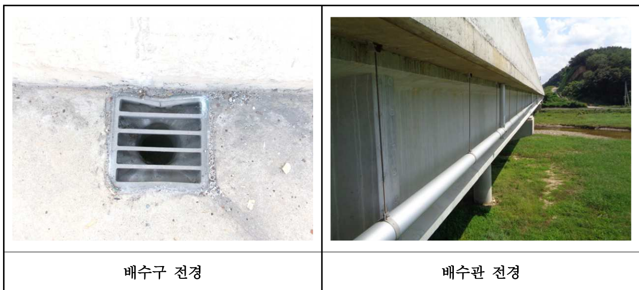
【사진 15.3.44】 배수시설 전경
