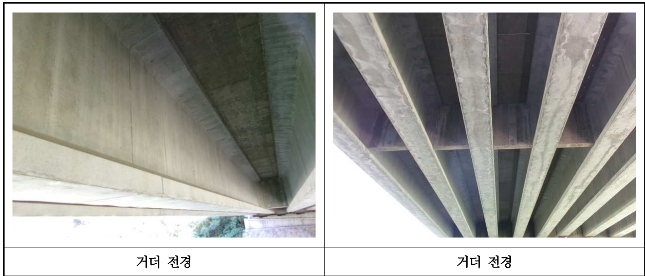
【사진 15.3.4】 거더 전경
