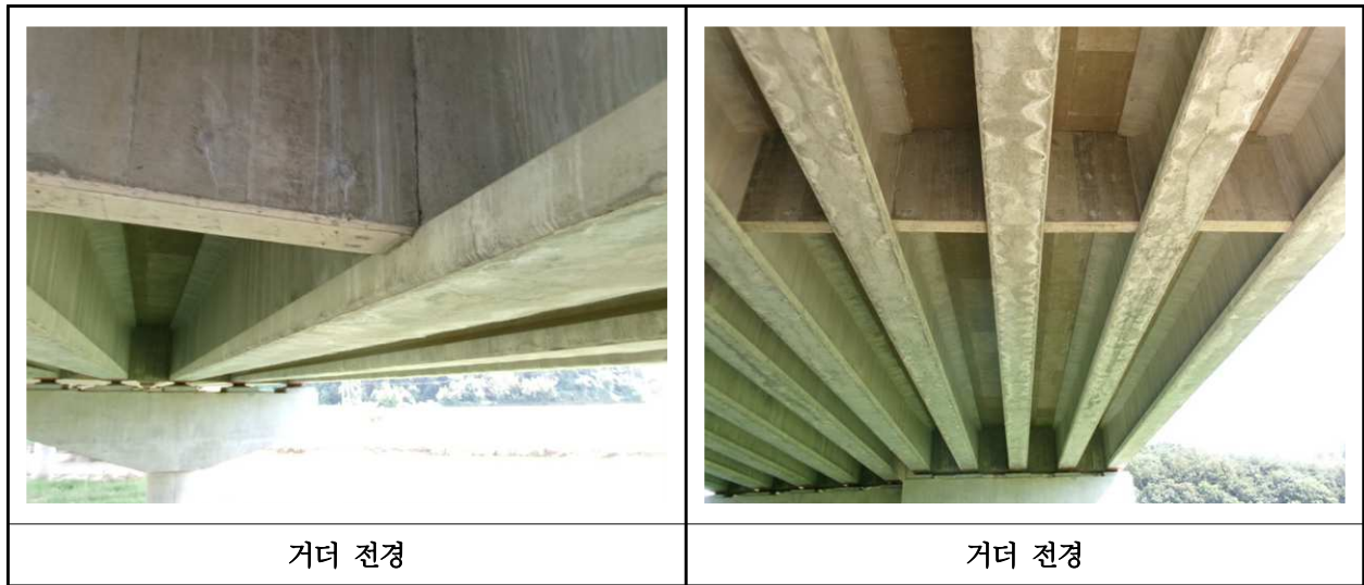
【사진 15.3.27】 거더 전경
