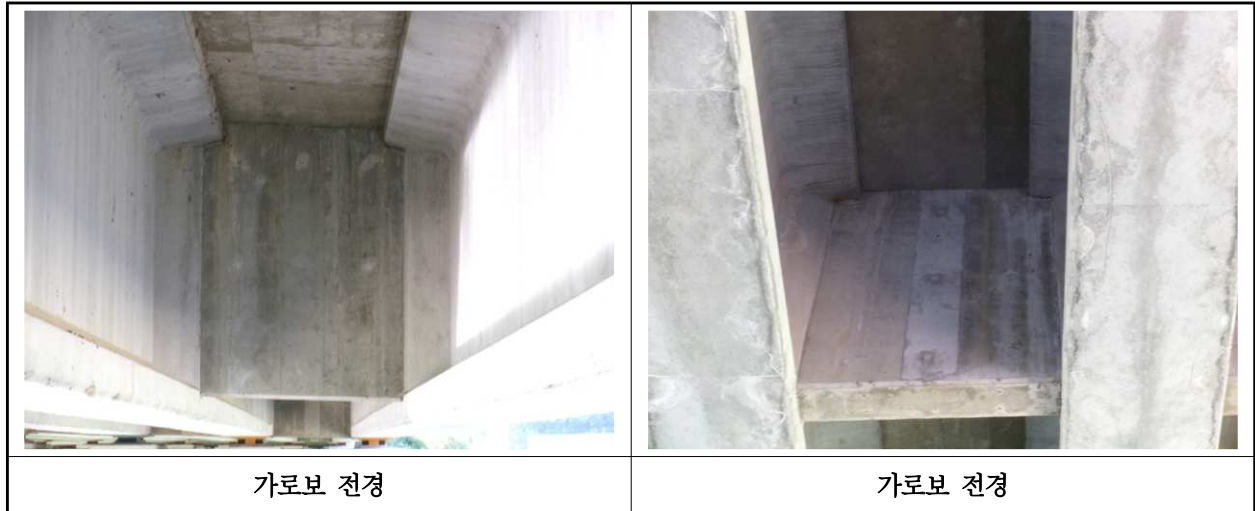
【사진 15.3.6】 가로보 전경
