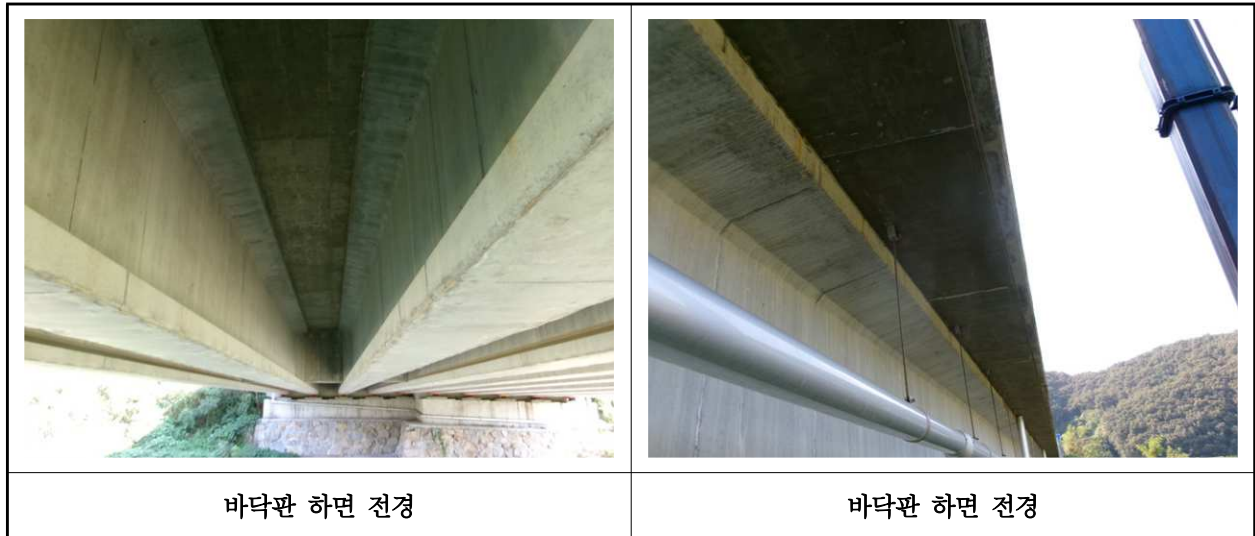
【사진 15.3.2】 바닥판하면 전경
